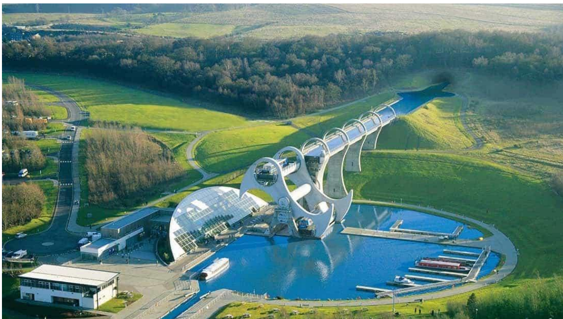
A Falkirk Wheel nevű hajóátemelő Skóciában – forrás: scottishcanals.co.uk
