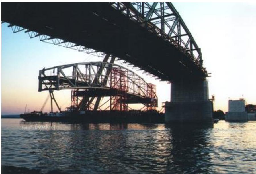
Az esztergomi híd újjáépítése (2011) – forrás: hidfotok.hu
